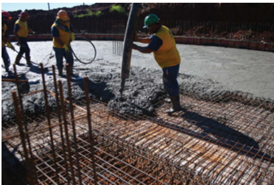
Figura 1.4 – Concretagem de estrutura de concreto
