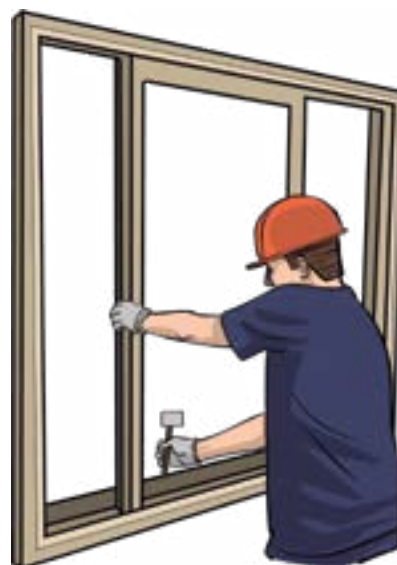
Colocação das esquadrias e de suas ferragens
