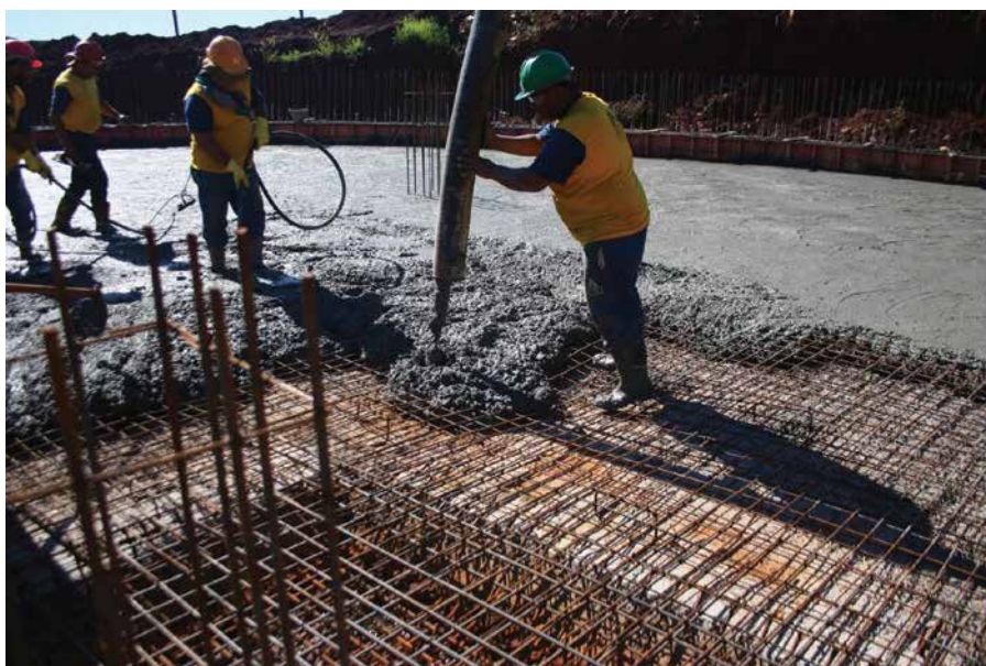
Figura 1.4 – Concretagem de estrutura de concreto
